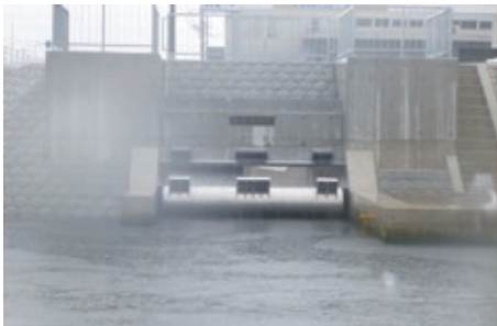
排水樋門・自動止水作動状況
