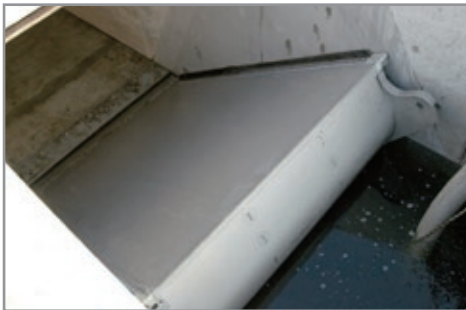
実施設備の自動作動性能検査状況
