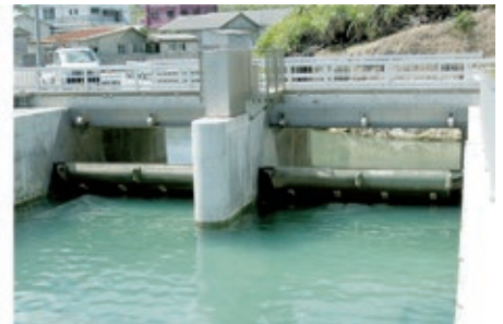
防潮水門・自動止水作動状況
