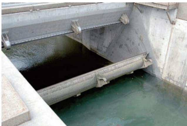
防潮水門の自動閉(逆流防止)作動状況
